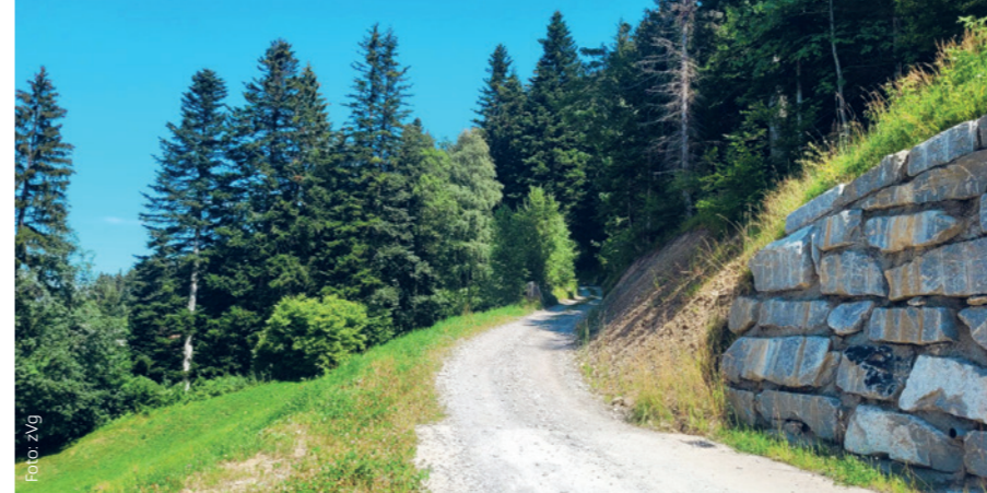
Der Weg für die ausstehenden Bauarbeiten in der Bergzone Ost ist frei. Der Gemeinderat genehmigte im September den Nachtragskredit.
