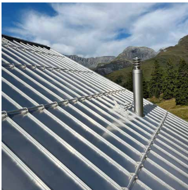
Neues Dach der Alphütte Ranasca dado
