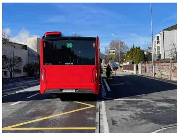
Sanierte Fahrbahnhaltestelle Tuma Platta mit hoher und langer Einstiegschwelle für den hindernisfreien Buseinstieg
