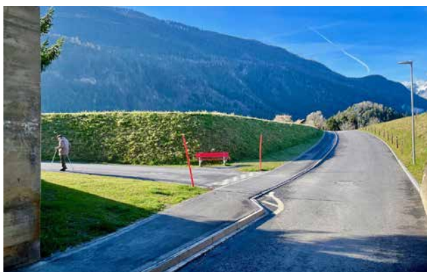
Sanierte Strasse Caschnés Süd mit Einmündung Navinal
