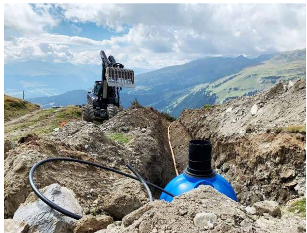
Einbau der neuen Wasserversorgung Alp Ranasca dado
