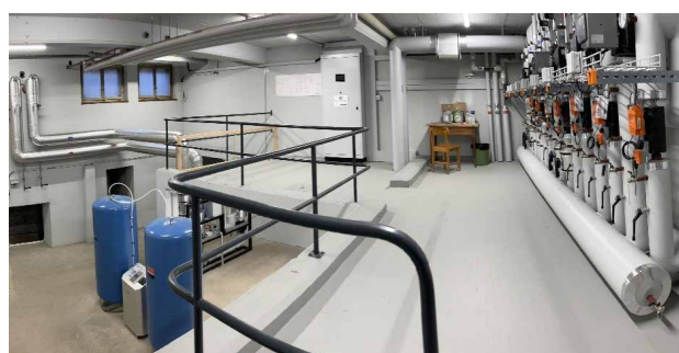
Totalumbau der Heizzentrale Tircal von Öl- und Holzsnitzelheizung auf Fernwärme
