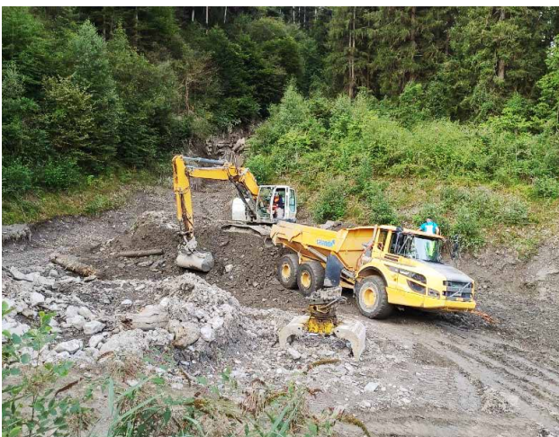
Räumung Geschiebefang Val Crap Rageth
