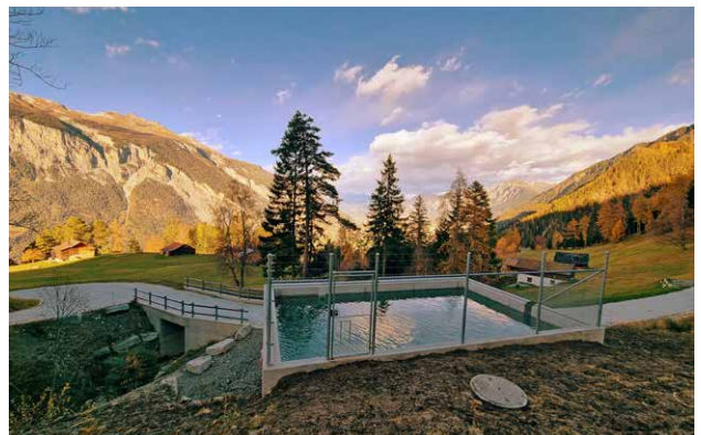
Löschwasserbecken Sum Crap
