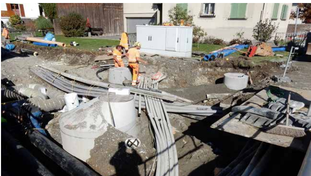
Strassensanierung und Aufweitung Einfahrt in die Kantonsstrasse, Schulweg Sum Curtgins
