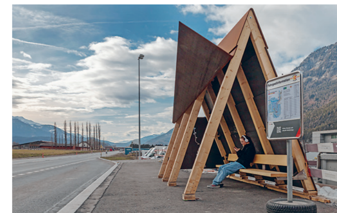
Prototyp der neuen Wartehäuschen am Kreisels Felsberg: optisch ungewöhnlich – aber ein moderner Blickfang.
