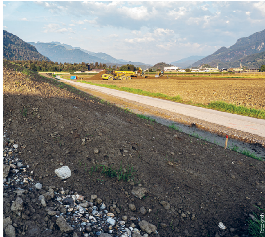
Der Veloweg Plarena führt am Schutzbauwerk Val Parghera vorbei und wird verbreitert, damit das Rufenmaterial sicher und reibungsfrei abtransportiert werden kann.
